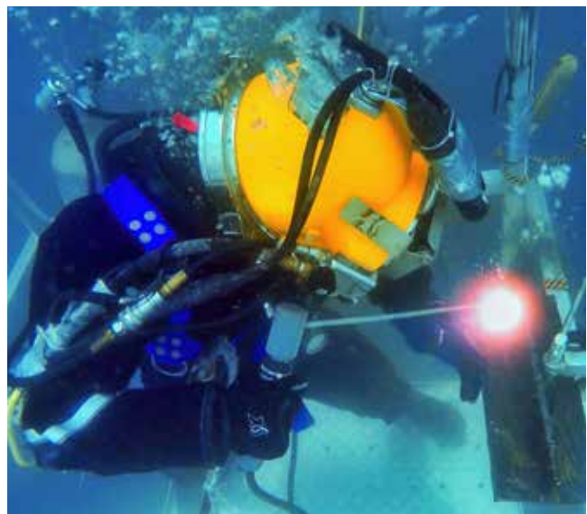
Figura 8. Buzo de Salvamento efectuando soldadura subacuática. Fuente: DCOES
