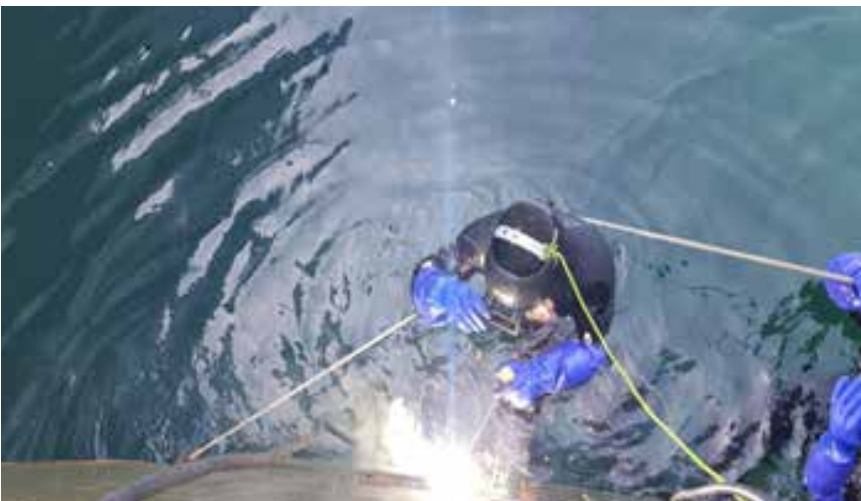
Figura 4. Buzo efectuando soldadura con el cuerpo sumergido hasta el pecho. Fuente: DEBUS.
