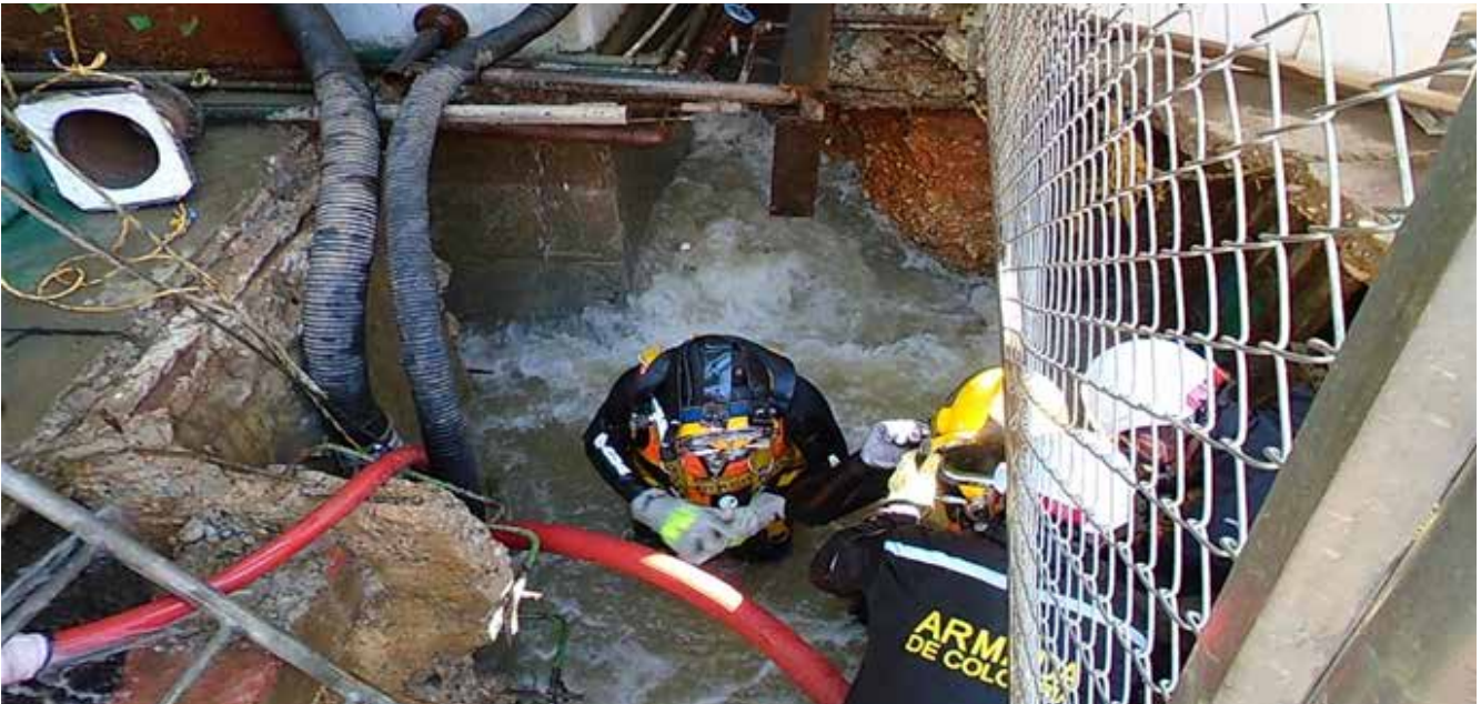
Figura 2. Buzos de salvamento efectuando inspección subacuática a la tubería averiada. Fuente DEBUS
