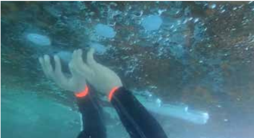
Figura 3. Buzo instalando el producto BELZONA 1111 para controlar la avería subacuática. Fuente : DEBUS
