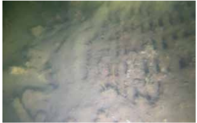
Figura 18. Rejilla caja de mar sector quilla de balance. Fuente: Departamento de Buceo y Salvamento Armada de Colombia.
