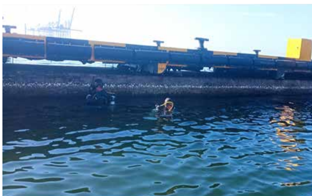
Figura 1. Buzos realizando inspección subacuática de seguridad a instalación portuaria. Fuente: Batallón de Fuerzas Especiales Armada de Colombia
