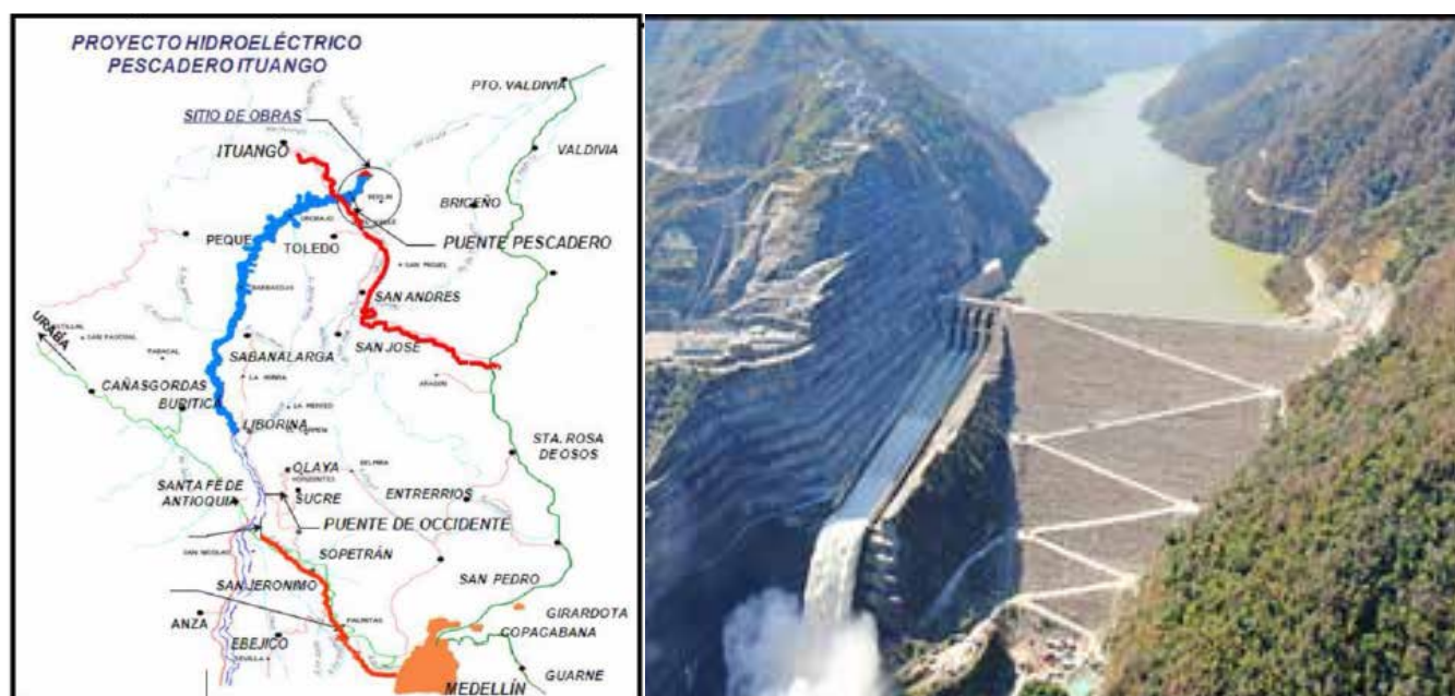
Figura 1. Proyecto Hidroeléctrico Ituango.
