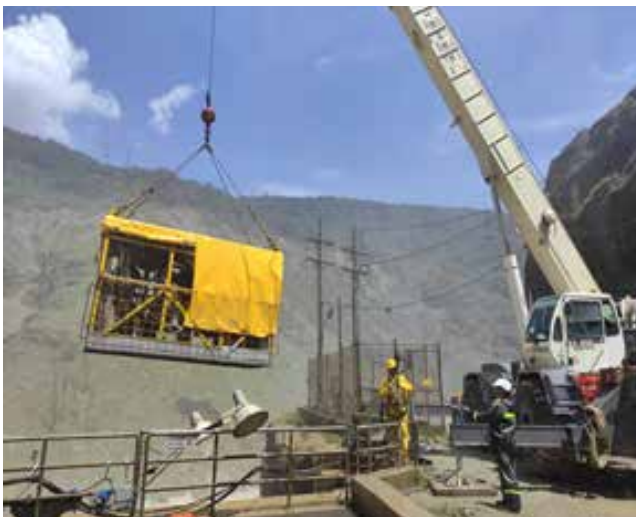
Figura 1. Proyecto Hidroeléctrico Ituango.
